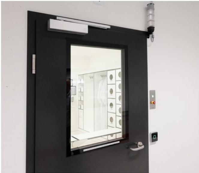
Blick in die Personalschleuse des neuen Reinraums. Oberhalb der Tür wurde eine RMS-Anzeigeleuchte angebracht, die im Notfall akustisch und visuell Alarm auslöst.
