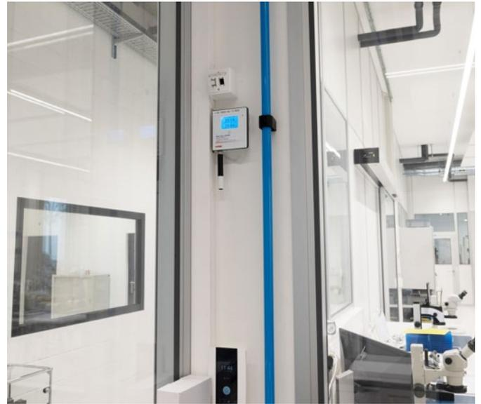
Die Messwerte, hier Temperatur und Feuchtigkeit, können sowohl an den einzelnen Datenloggern sowie auf dem Dashboard am Computer jederzeit überprüft werden.
