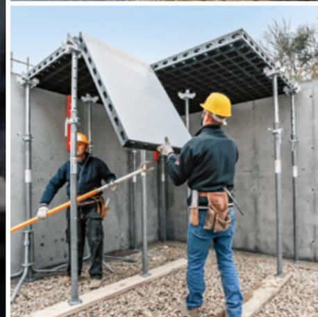
**DUO. Die neuartige Leichtschalung für Fundamente, Wände, Säulen und Decken**
