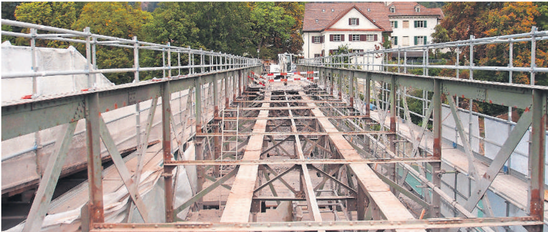
Anerkennungspreis 2016: Die denkmalgeschützte Eisenfachwerkbrücke über den Rhein bei Reichenau aus dem Jahre 1881 wurde durch Instandsetzungs- und Verstärkungsmassnahmen für weitere 40 Jahre Lebensdauer fit getrimmt. Die stillen und überzeugenden Eingriffe sind erst auf den zweiten Blick in ihrer Dimension spür- und begreifbar.
