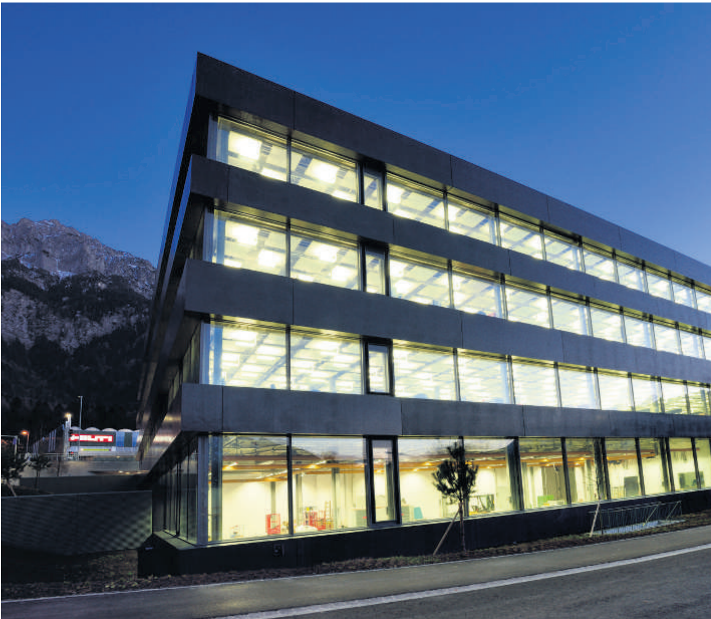
Prix Acier 2016: Strukturell setzt sich der Bau des Hilti-Innovationszentrums in Schaan FL aus einem hybriden Tragwerk zusammen, bei dem Stahl und Beton, aber auch Platten und Fachwerkträger im Verbund wirken.
