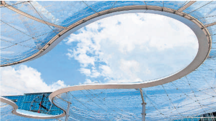
Busbahnhof Aarau: Ein höchst anspruchsvoller Stahlbau und das weltgrösste Folienkissen prägen das neue Wahrzeichen mitten in der Stadt Aarau.
