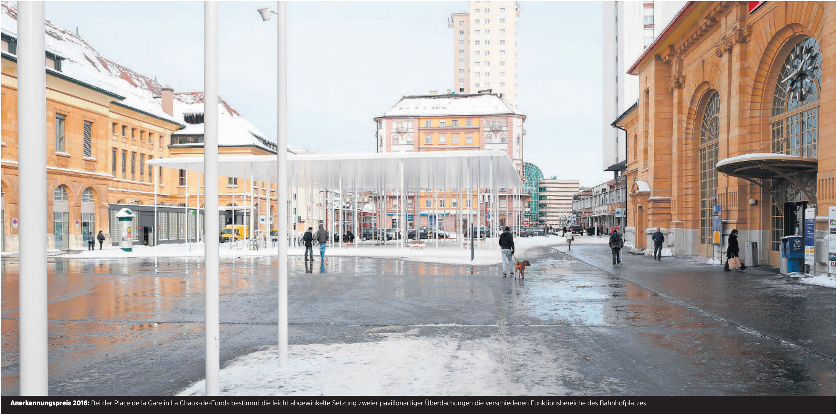
Anerkennungspreis 2016: Bei der Place de la Gare in La Chaux-de-Fonds bestimmt die leicht abgewinkelte Setzung zweier pavillonartiger Überdachungen die verschiedenen Funktionsbereiche des Bahnhofplatzes.
