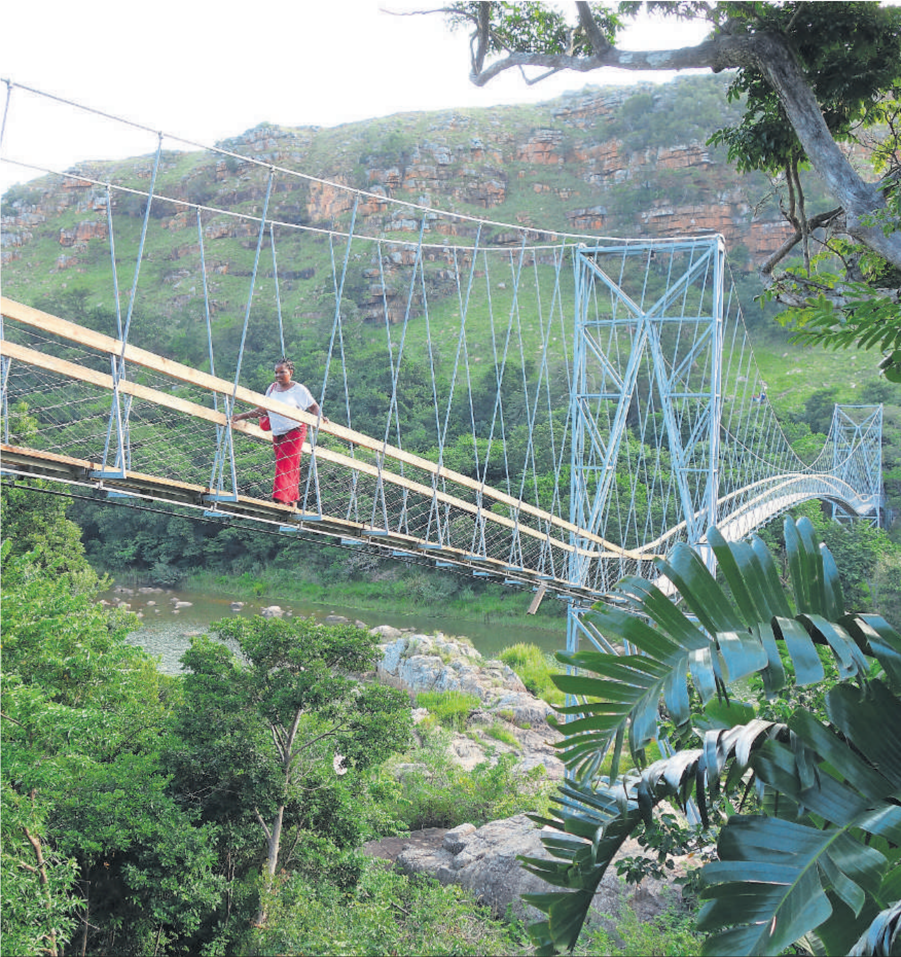
Prix Acier 2016: Die Hängebrücke über den Fluss Mzamba in Südafrika konnte dank Schweizer Ingenieurkunst mit einheimischen Hilfskräften lokal gebaut werden.
